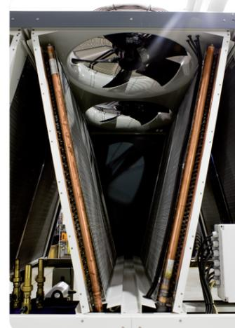
Die Konfiguration mit modularen „V“-förmigen Wärmetauschern ermöglicht größere Wärmetauscherflächen und demzufolge eine hohe thermische Effizienz im Verhältnis zur Aufstellfläche des Geräts. Die Ausführung Free-Cooling verfügt über Wärmetauscher, die so bemessen sind, dass eine totale Freikühltemperatur (Total Free-Cooling Temperature – TFT) von 10 °C\* erreicht wird.
